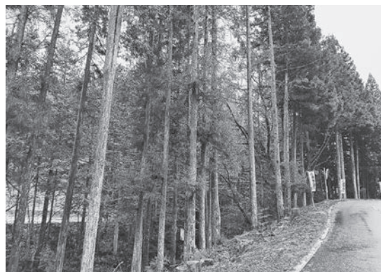
軒川地区で支障木伐採しました。
