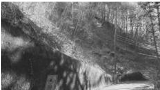
村道29力石鈴ヶ沢線板橋
