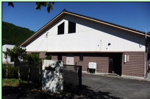
売木村浄化センターの建屋
